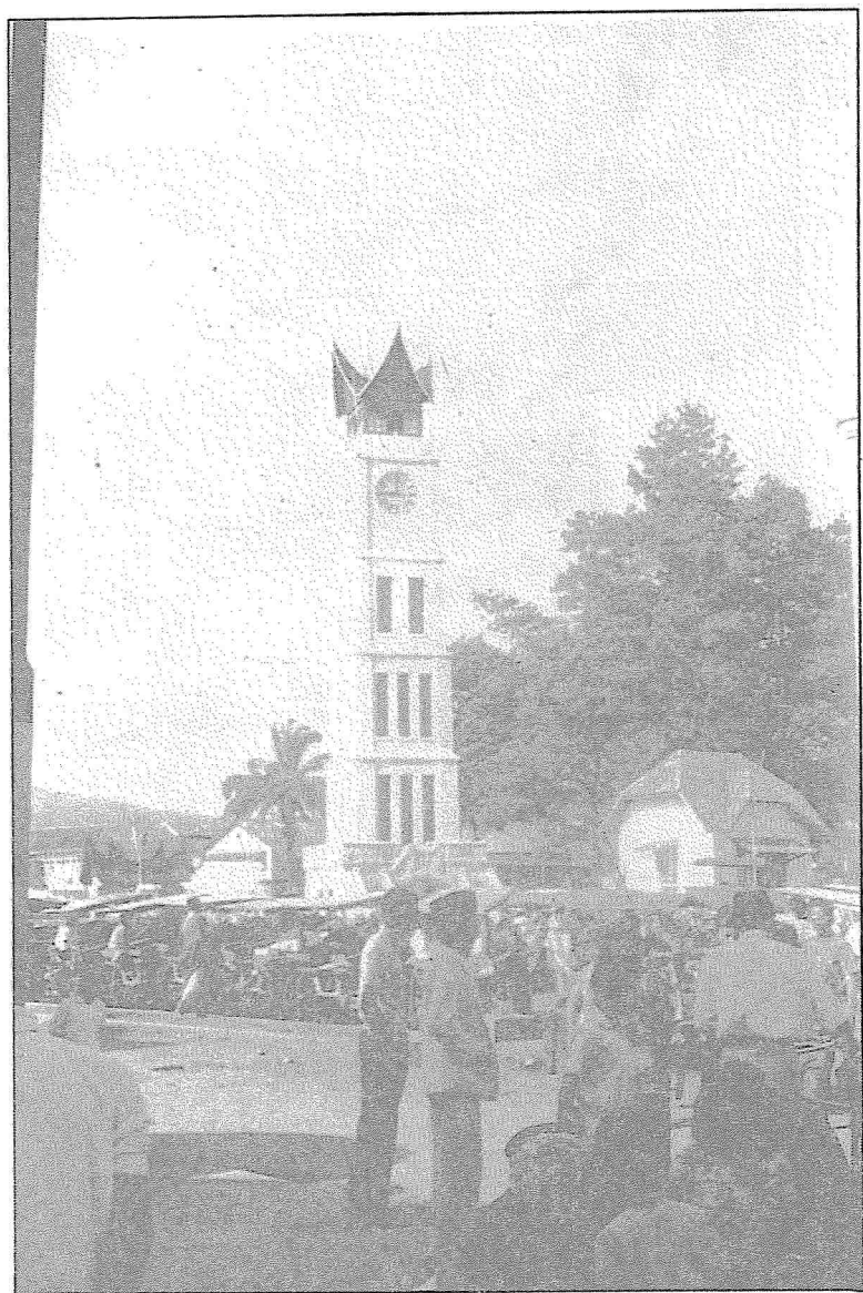
Jam Gadang di Bukit Tinggi
