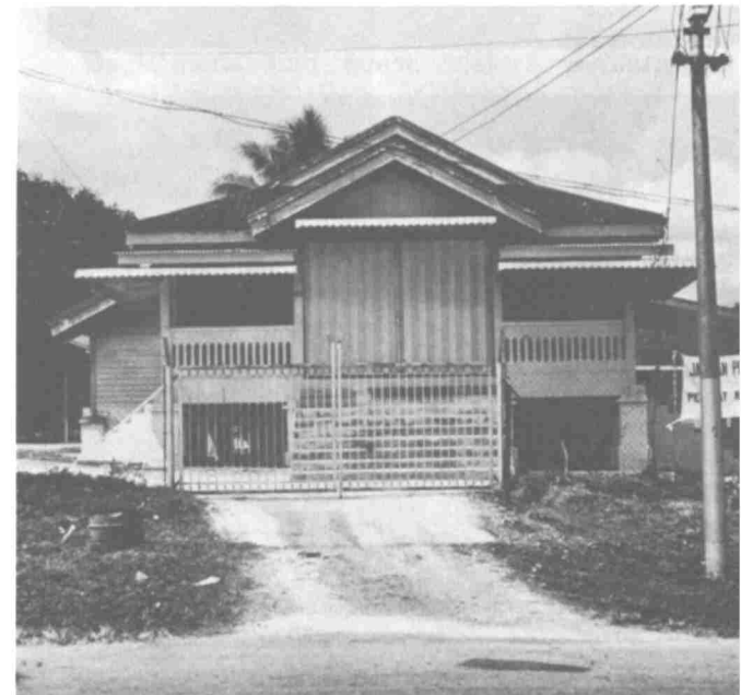
Cawangan Jabatan Pengangkutan Jalan diwujudkan diKuala Pilah untu kemudahan Umum
