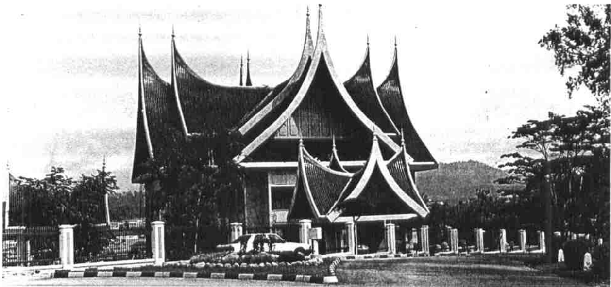
Dewan Undangan Negeri baru yang terletak dalam perkarangan Wisma Negeri menyertahkan ciri-ciri budaya yang tinggi sebagai mercu tanda yang membanggakan rakyat Negeri Sembilan.
