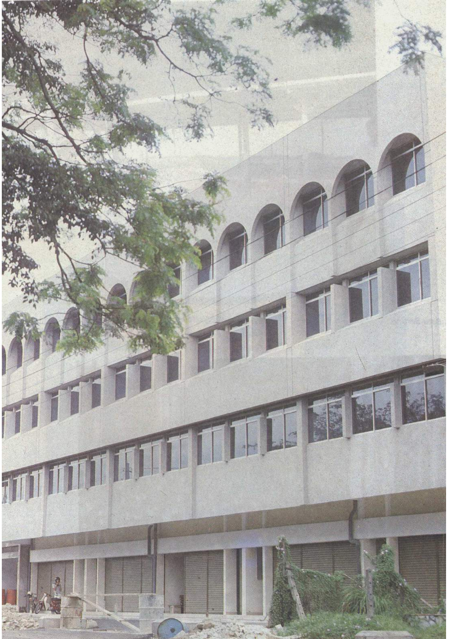
Bangunan Persatuan Bekas Prajurit
